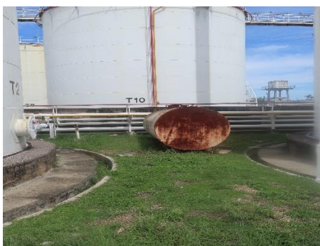
รูปที่ 2-10 ถังเก็บตะกอนขนาด 18,000 ลิตร
