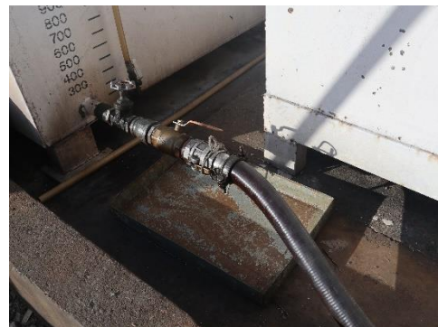
รูปที่ 2-4 ถาดเหล็กป้องกันการรั่วไหล
