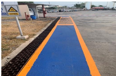
รูปที่ 2-8 ตะแกรงดักมูลฝอยบริเวณรางระบายน้ำฝน
