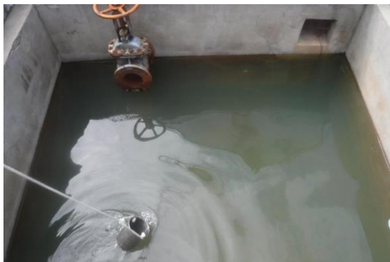
รูปที่ 2-27 บ่อบำบัด API ที่เก็บกักน้ำฝนที่ตกบนท่าเทียบเรือ
